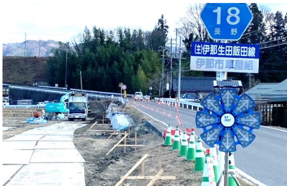
（車屋地籍の拡幅工事現場）
